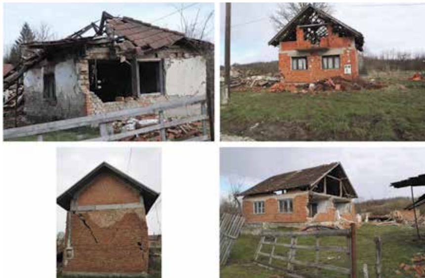
Slika 24. Fotografije nekih teško oštećenih i urušenih kuća u selu Majske poljane
