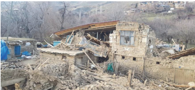
Slika 24. Srušena zidana kuća u donjem dijelu sela Cevrimtaş (građevina br. 3)
