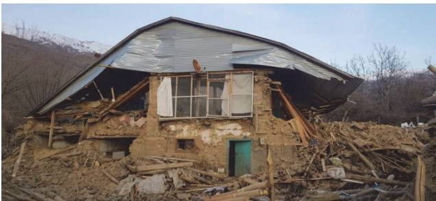
Slika 23. Srušena zidana kuća u donjem dijelu sela Cevrimtaş (građevina br. 2)
