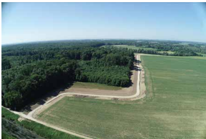
Pogled na novoizgrađeni nasip u Benici
