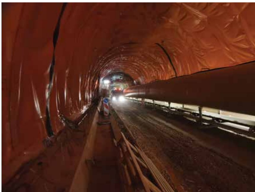
Hidroizolacija tunela
