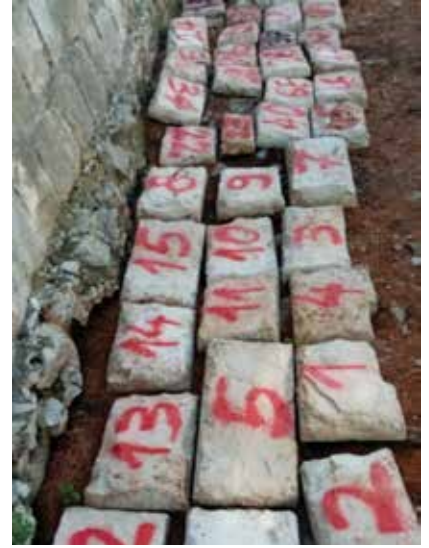
Kameni materijal sačuvan je i ponovo upotrijebljen u gradnji
