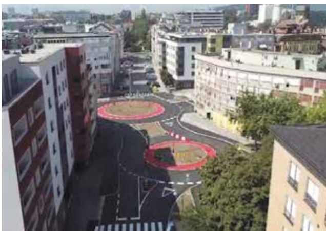
Prikaz izvedenoga tehničkog rješenja rekonstrukcije raskrižja (izvor: TRASA ADRIA d.o.o., Zagreb)
