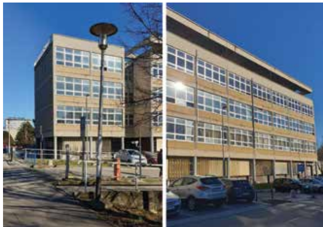
Pogled na dilataciju A – južno pročelje
