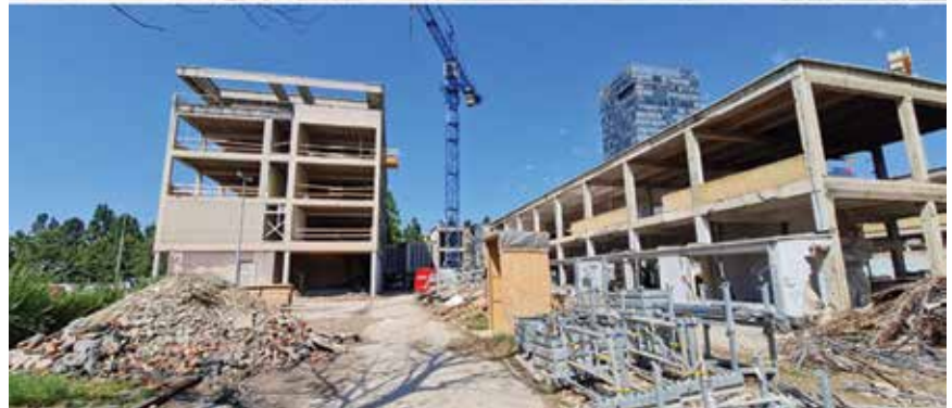
Rušenje zgrada A, B i C
