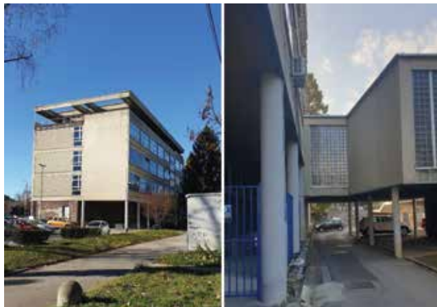
Pogled na dilataciju A – istočno pročelje i spojni objekt
