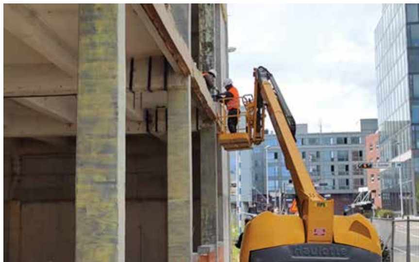
Ovijanje stupova FRP trakama na dilataciji B3
