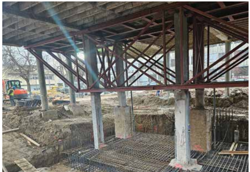
Izvedba razuporne konstrukcije na zgradi A
