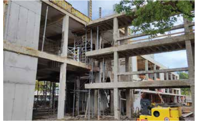
Izvedba stubišta na spoju dilatacije B3 i D
