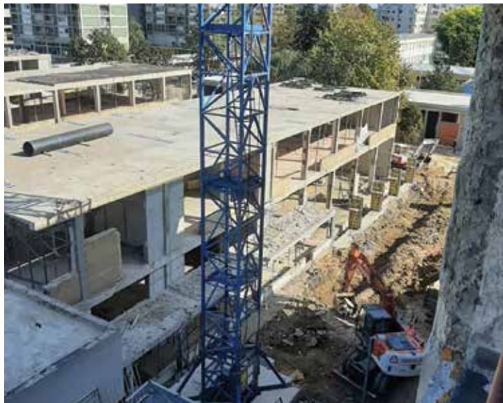
Skidanje slojeva krova na B dilatacijama Uklanjanje svih slojeva i parapeta na dilataciji A
