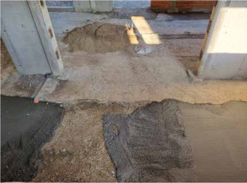
Izvedba novih podova
