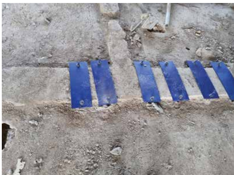
Izvedba ojačavanja greda
