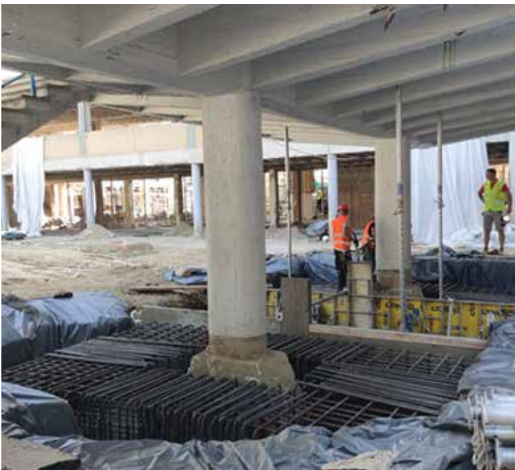
Ulazni most u dilataciju A – radovi ojačanja temelja
