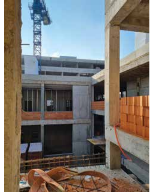
Zidarski radovi na parapetima
