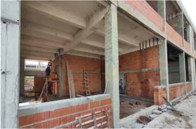
Zidarski radovi na dilataciji B3
