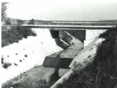
Slika 17. Betonski pločasti propust i stuba na vodotoku Kaznici, 1973.
