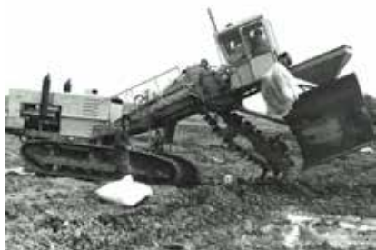
Slika 16. Stroj za ugradnju drenažnih PVC cijevi sustava podzemne odvodnje, 1978.
