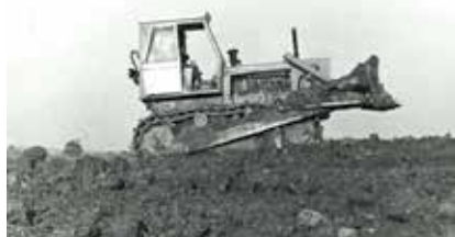
Slika 13. Dozer na razastiranju zemlje na regulaciji Biđa u Cerni, 1970.
