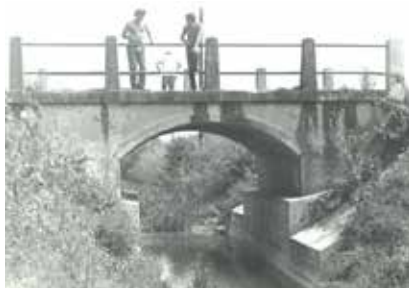
Slika 18. Svođeni betonski propust s produljenjem dna na vodotoku Vidaru
