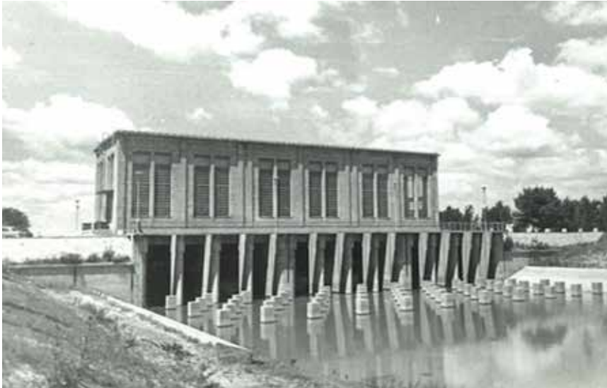
Slika 7. Crpna stanica na ušću Bosuta u Savu ( Q = 30 \text{ m}^3/\text{s} ), 1960. – 1976.
