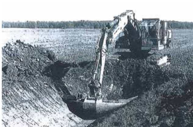
Slika 11. Bager "hidraulik" – iskop melioracijskoga kanala IV. reda
