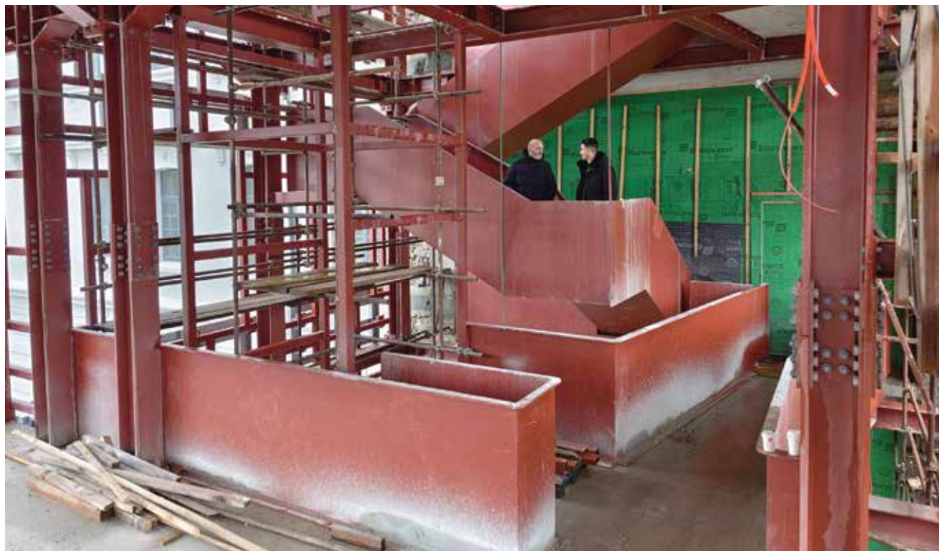
Izvedba nožice, ovješeno stubište
