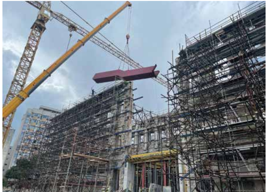
Montaža čeličnog stubišta
