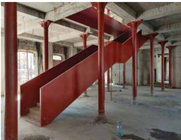
Čelično stubište u prizemlju sjevernog dijela
