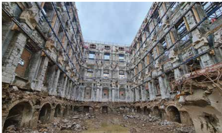
Uklonjena kompletna konstrukcija unutar vanjskih kamenih zidova
