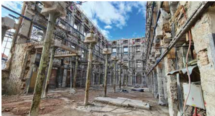
Uklanjanje postojeće konstrukcije unutar vanjskih kamenih zidova
