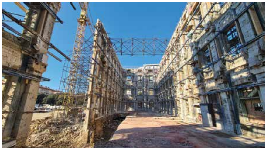
Postojeći kamene zidovi pridržani skelom; uklanjanje konstrukcije suterena
