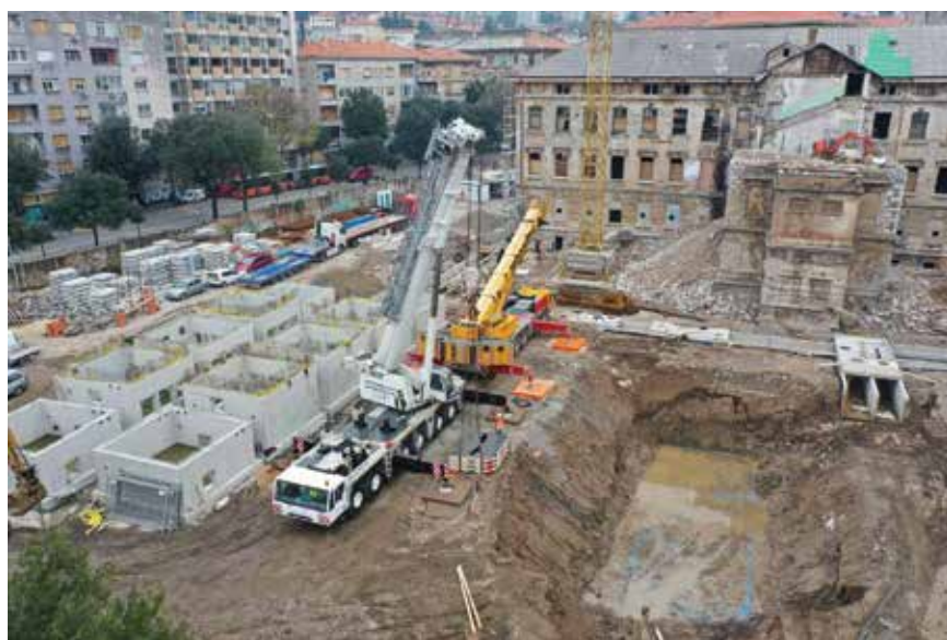
Polaganje retencija i crnih stanica; rušenja nožice T-objekta u pozadini
