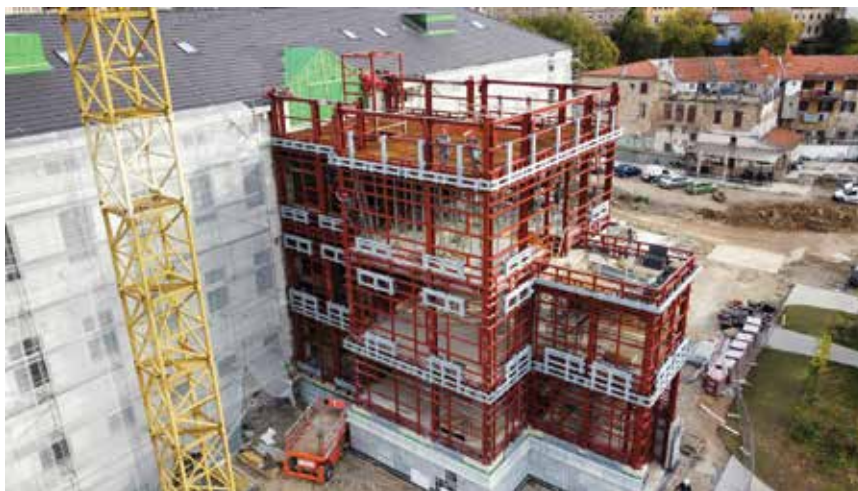
Montaža čelične konstrukcije nožice
