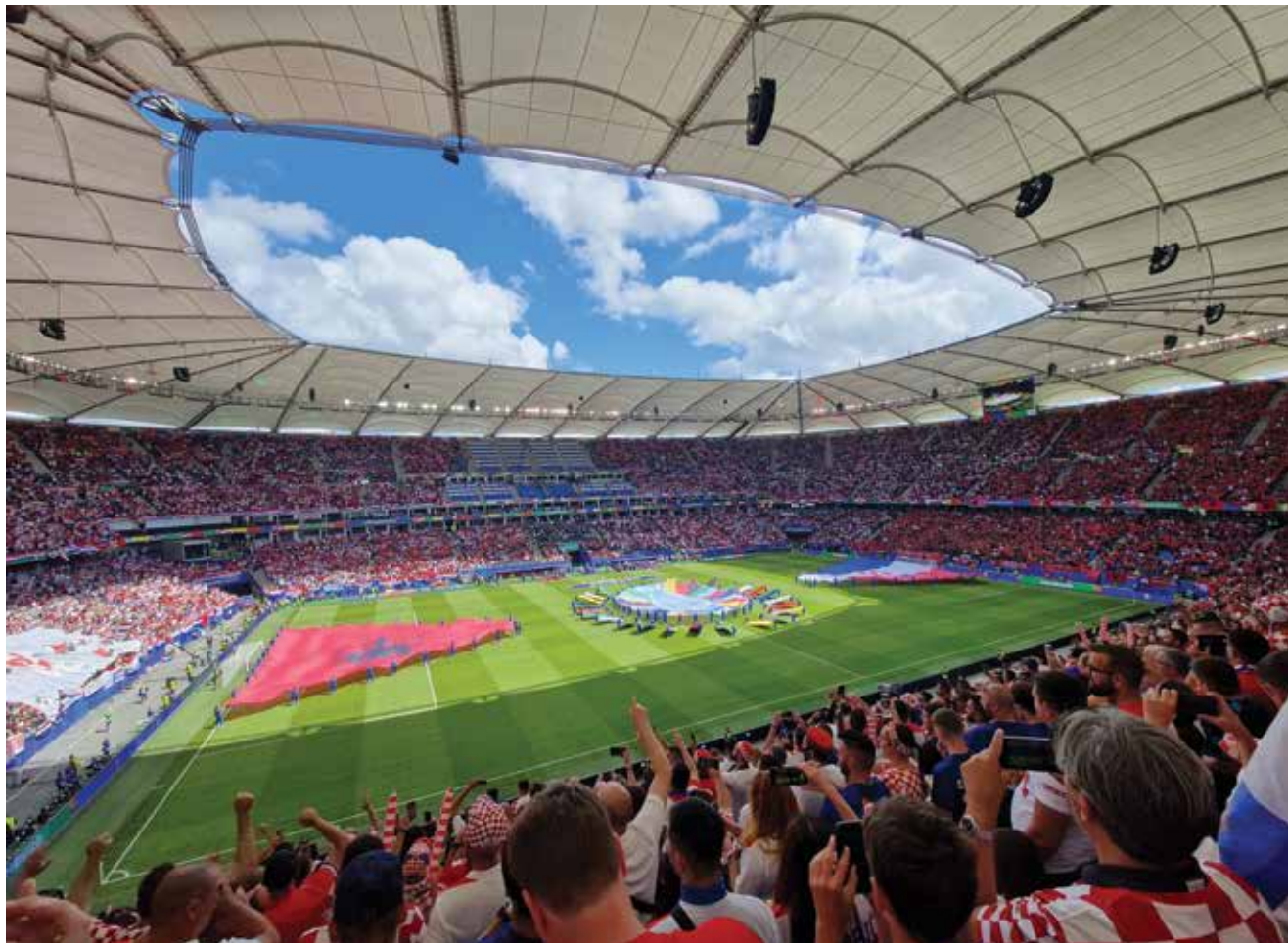
Volksparkstadion Hamburg prvijenac je među građevinama koje natkriva krov kabelskog sustava pravokutnog oblika
