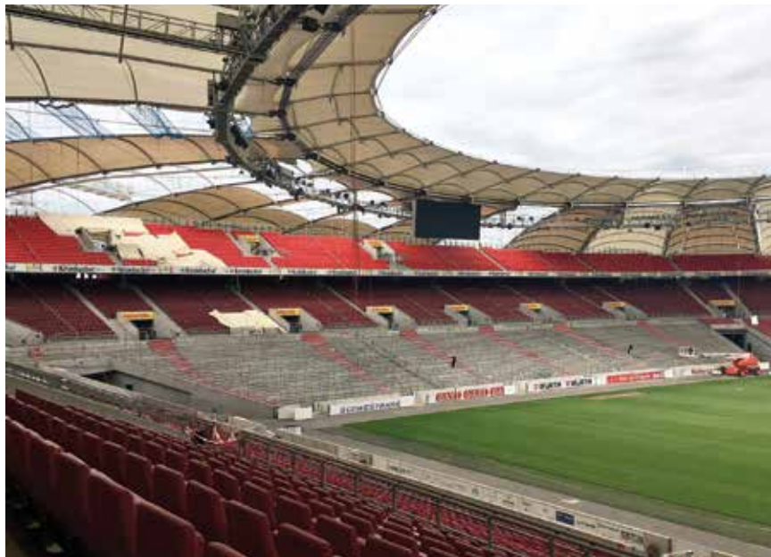
Stuttgart arena – pričvršćivanje krovnih panela na sekundarnu konstrukciju
