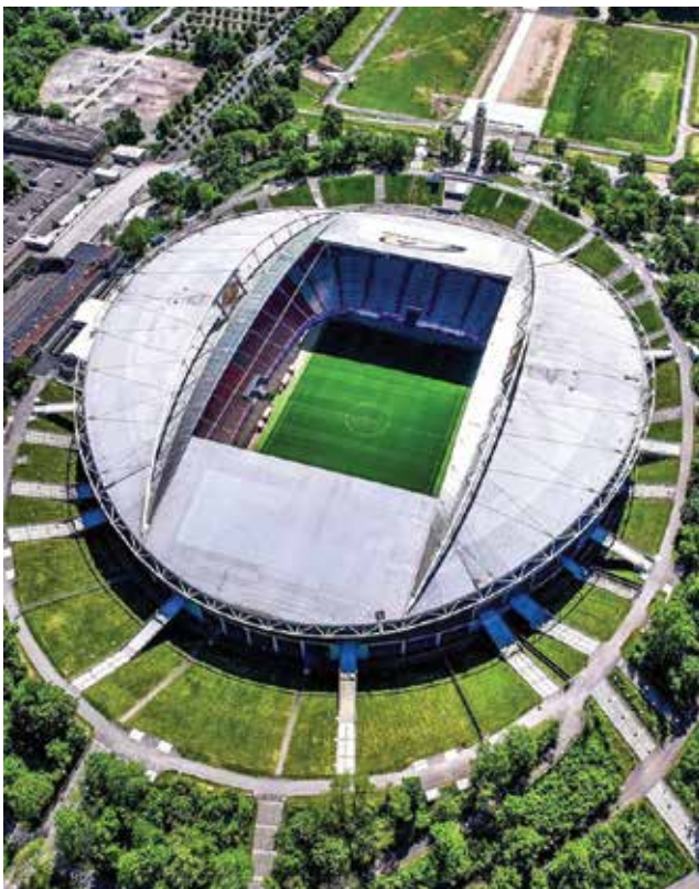
Stadion u Leipzigu je oblika elipse, a njegovi radijalni rešetkasti nosači su promjenjive dužine
