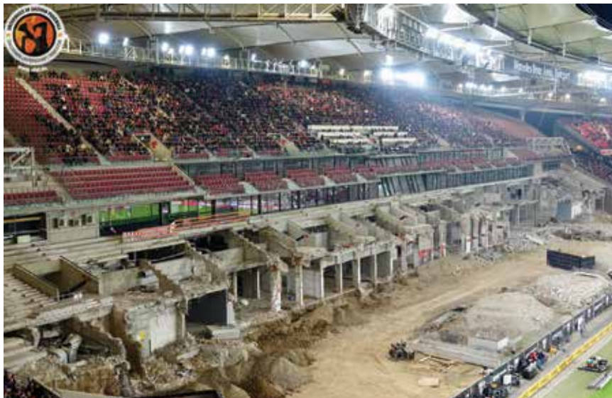
Tijekom rekonstrukcije stadiona u Stuttgartu osigurano je nesmetano odvijanje sportskih događaja
