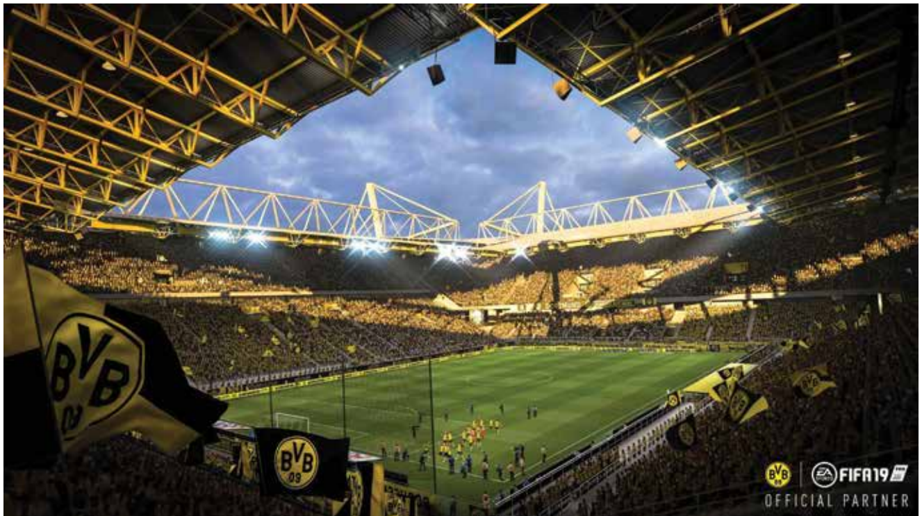
BVB stadion Dortmund – tribine i krovna konstrukcija
