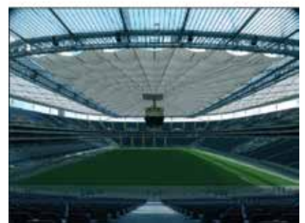
Proces zatvaranja krova stadiona u Frankfurtu
