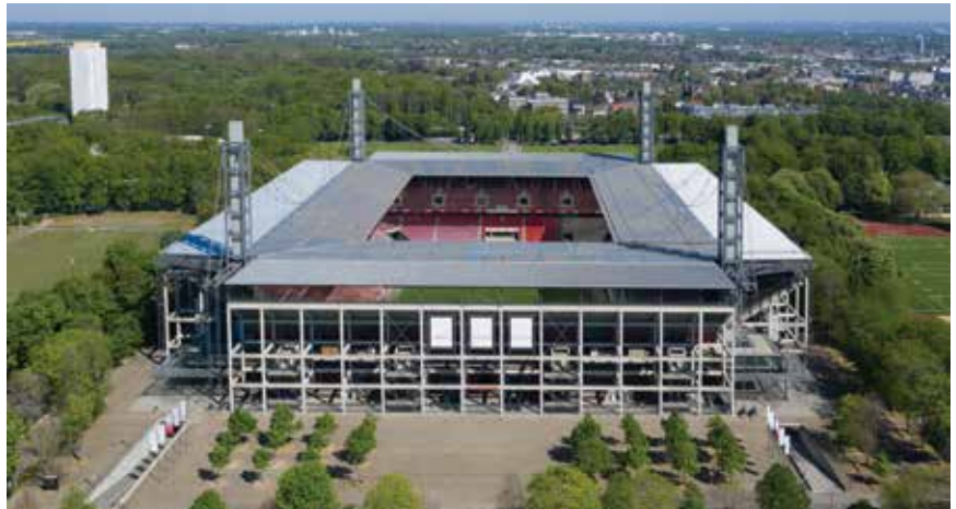
Stadion u Kelnu je pravokutna konstrukcija s četiri prepoznatljiva pilona u svojim kutovima
