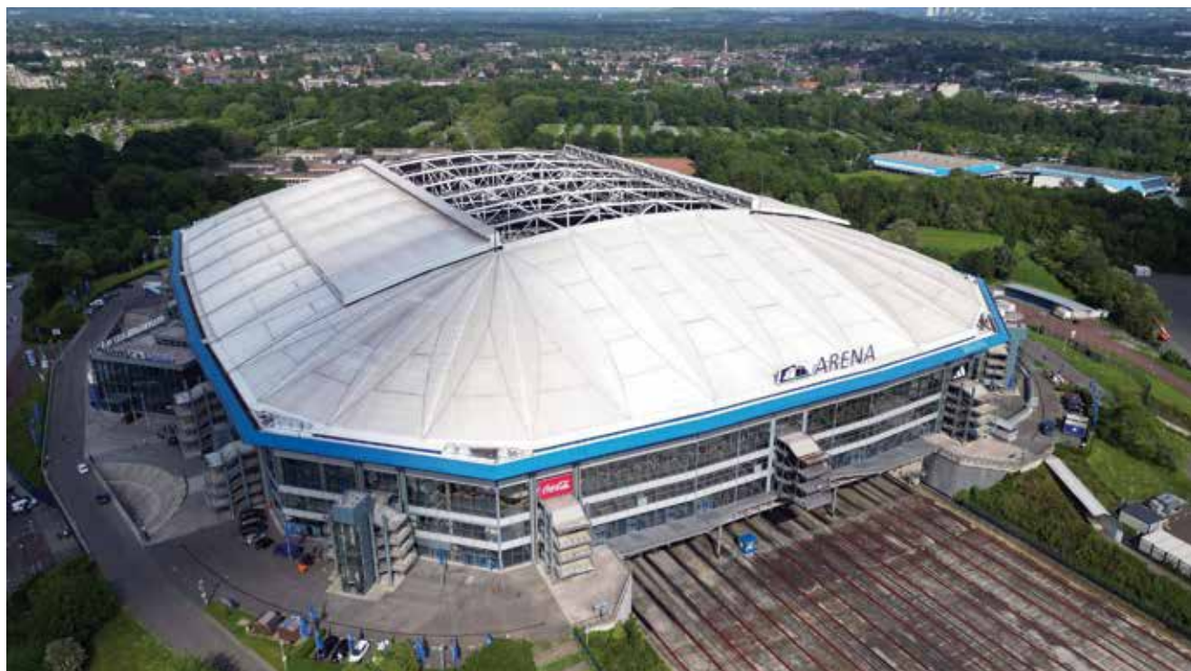
Arena Aufschalke u Gelsenkirchenu ima pomični krov koji se u potpunosti može zatvoriti
