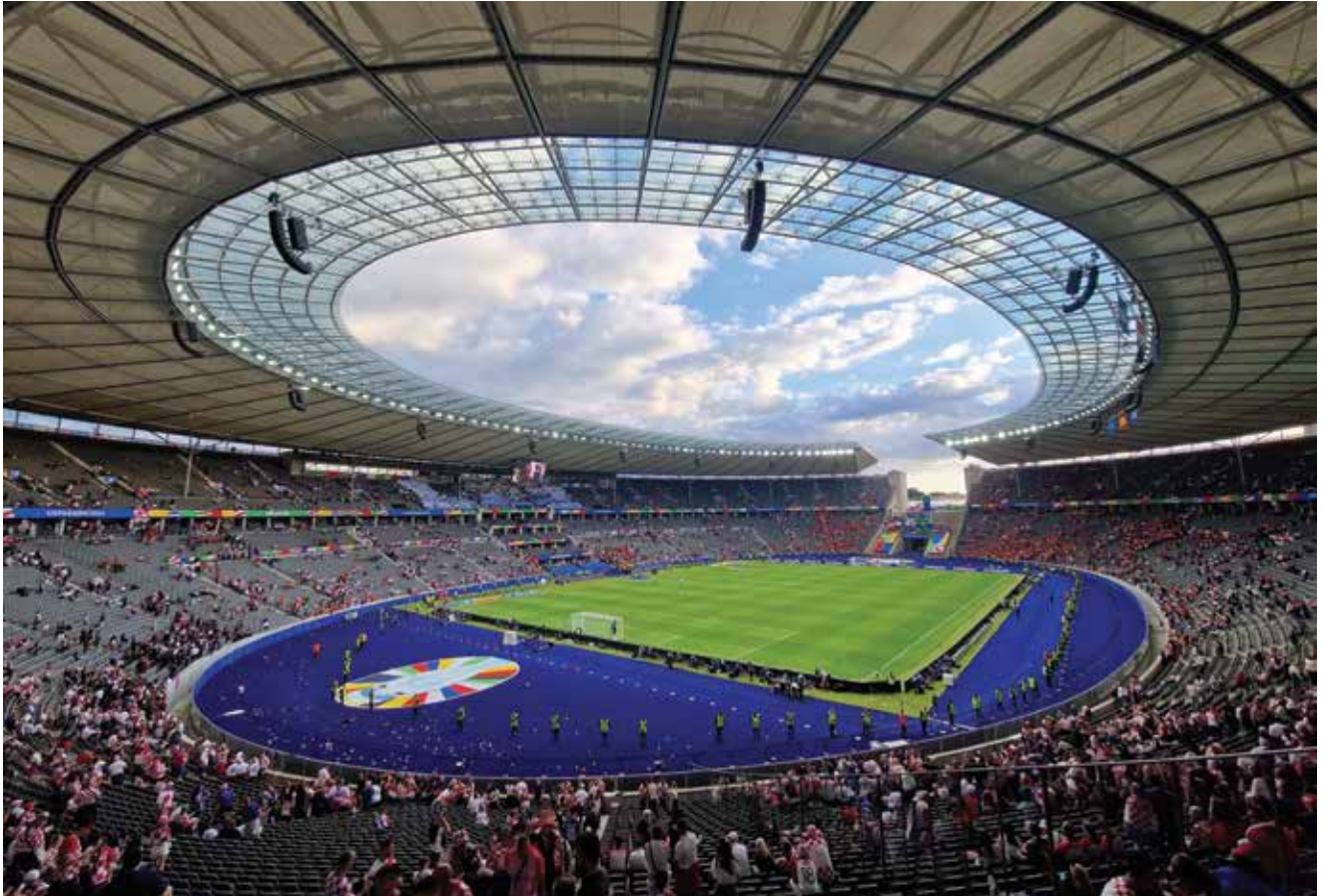
Pogled na tribine i čelično krovništvo Olimpijskog stadiona u Berlinu
