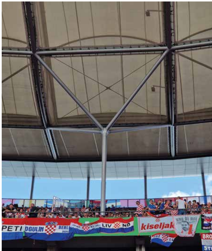
Vitki čelični stup podupire krovšte berlinskog stadiona
