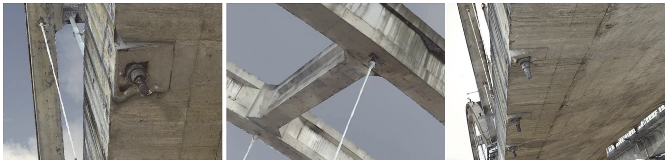
Slika 19. Detalji gornje konstrukcije mosta odozdo
