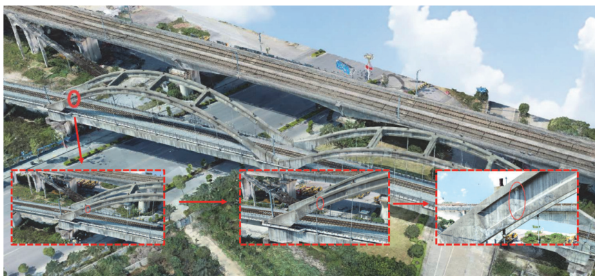
Slika 18. Iscvjetavanje na površini lukova
