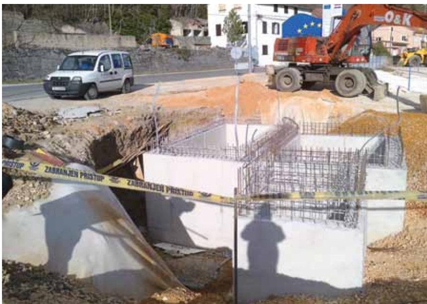
Armiranobetonski radovi na jednoj novoj crpnoj stanici
