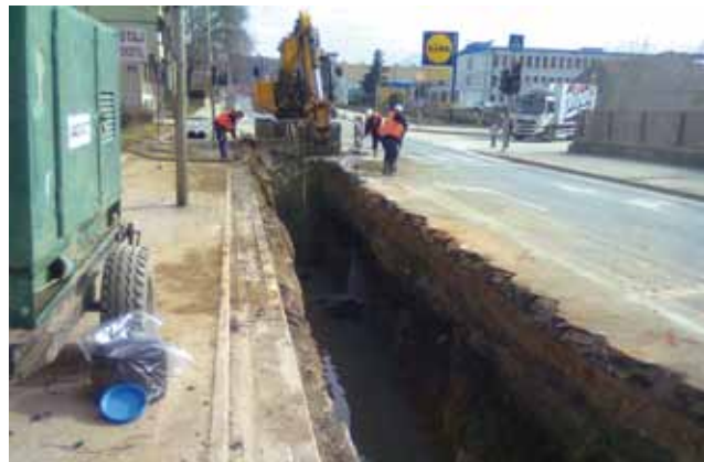
Ugradnja kanalizacijskih cijevi u Ulici 4. gardijske brigade
