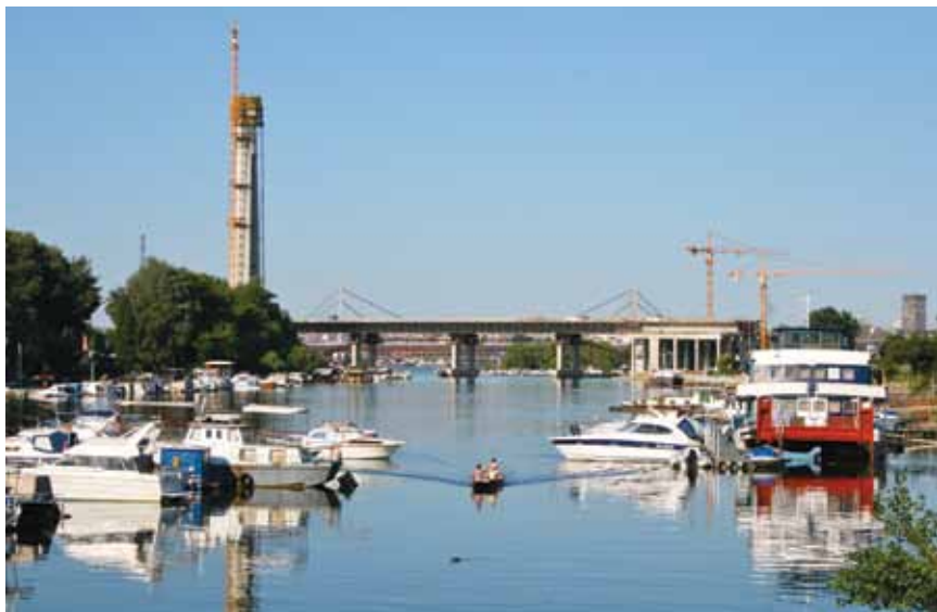
Gradnja pilona i stražnjeg raspona
