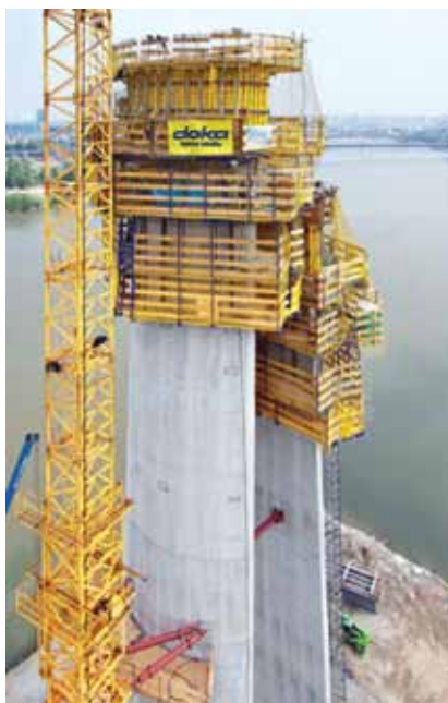
Gradnja pilona kliznom oplatom
