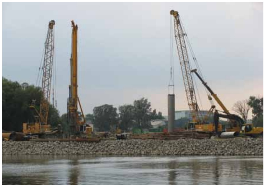
Radovi na temeljenju mosta
