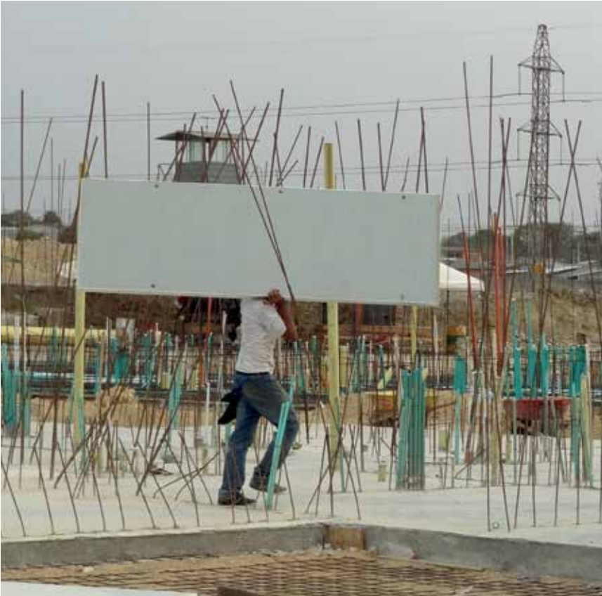
Radnici ručno premještaju laganu i jednostavnu oplatu
