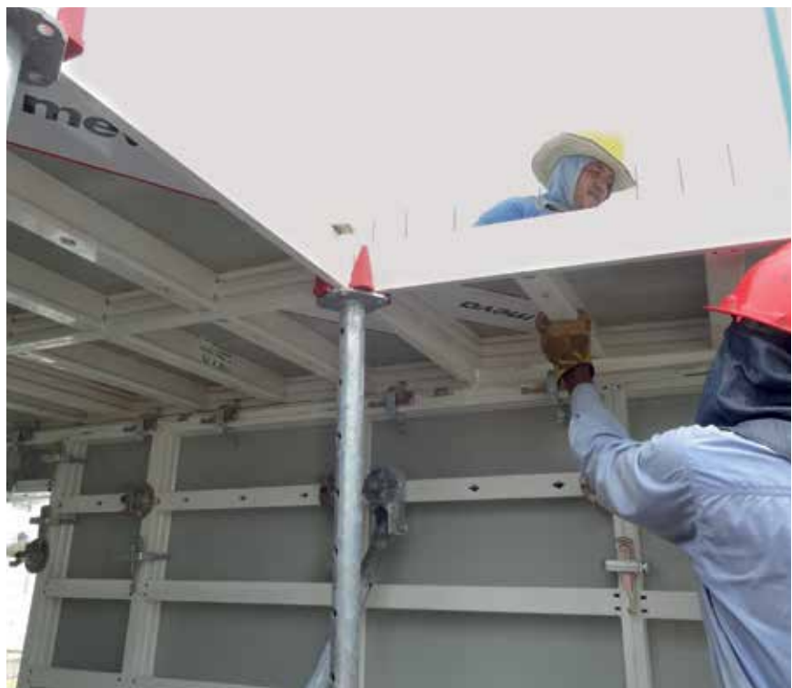
Poseban način pričvršćivanja oplata za brzu monažu i demontažu
