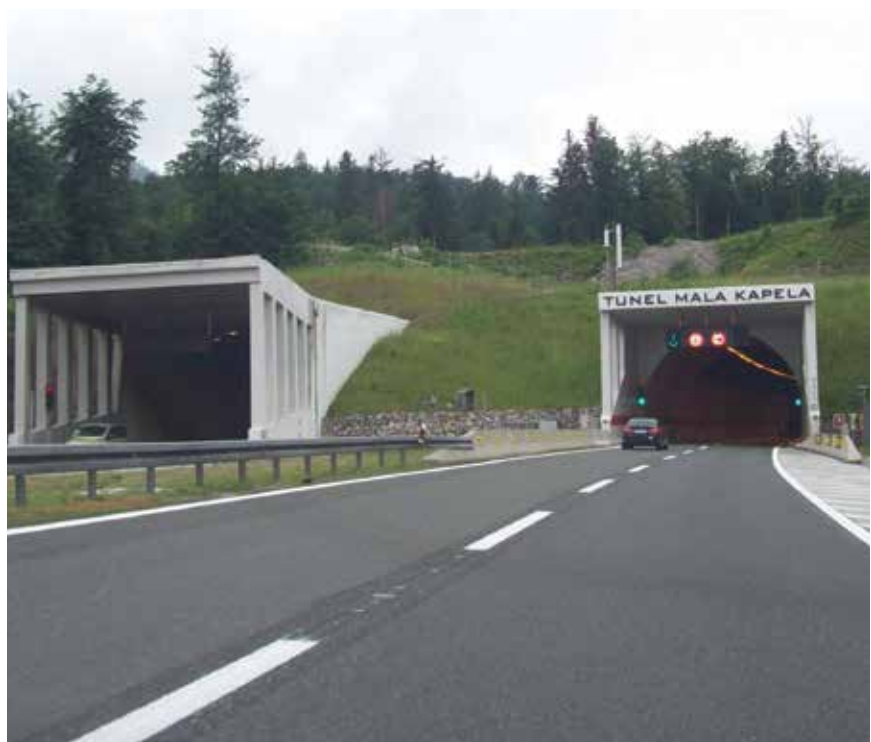
Južni portal tunela Mala Kapela
