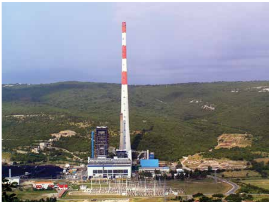
Građevine TE Plomin II s dimnjakom koji je najviša građevina u Hrvatskoj (340 m)
