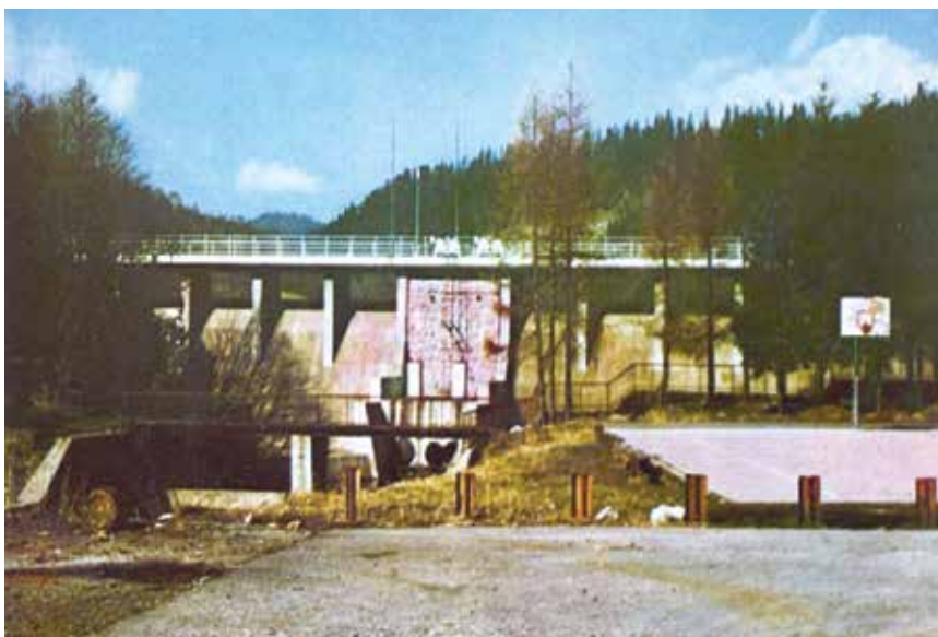
Betonska brana na jezeru Bajer, izgrađena 1951.
