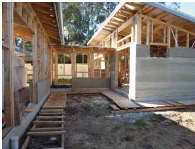
Gradnja blokovima od konoplje i vapna
