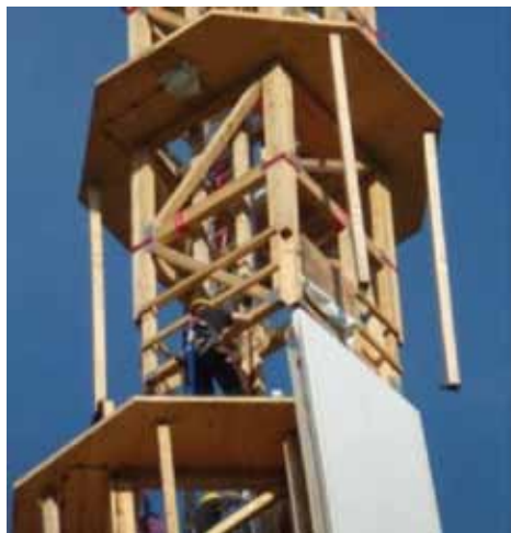
Gradnja drvene konstrukcije vjetrenjače
