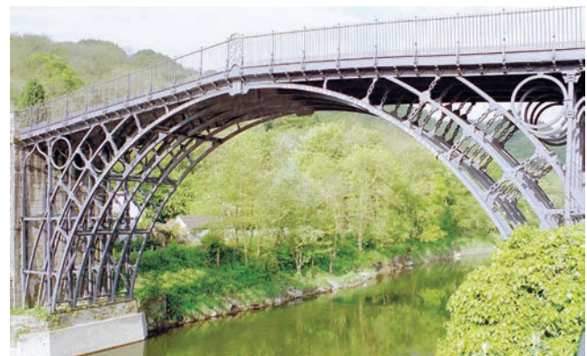
Most Coalbrookdale, prvi lučni most od kovanog željeza
