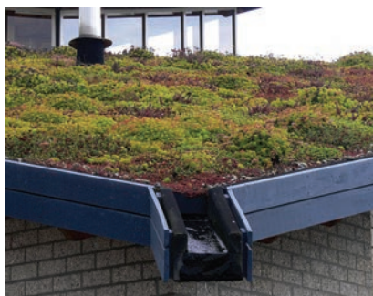
Detalji zelenih krovova, primjeri rješenja oluka
