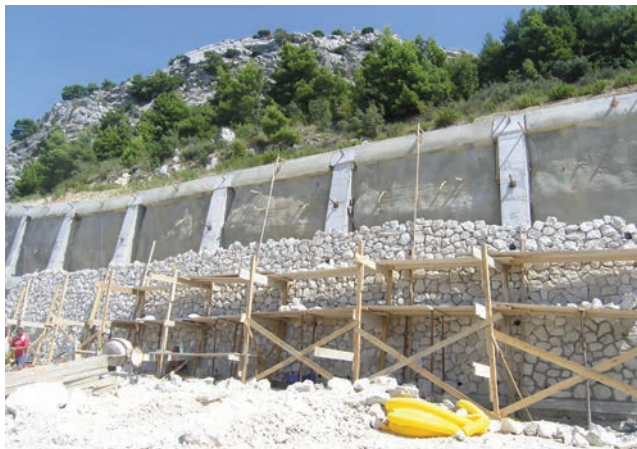
Oblaganje kamenom potpornog zida (drugi posjet)
