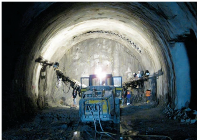
Početak radova u tunelu Omiš (2010.)
