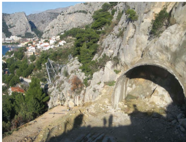
Istočni portal tunela Brzet uoči iskopa
