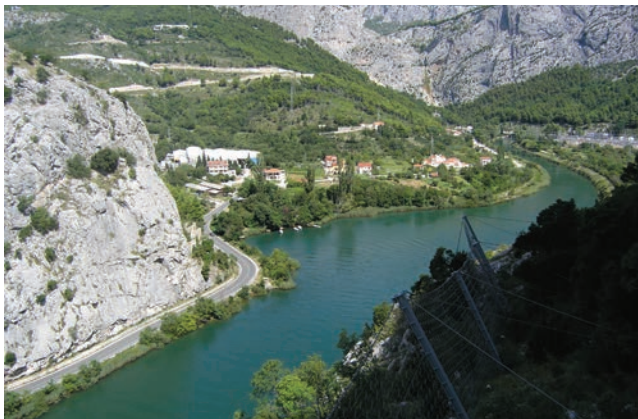
Dio kanjona Cetine i zaštitne mreže ispod zapadnog portala tunela Omiš
