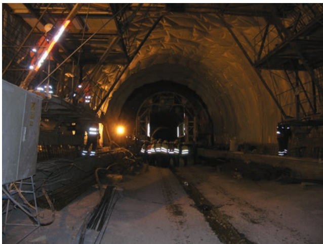
Detalj iskopa tunela Omiš
