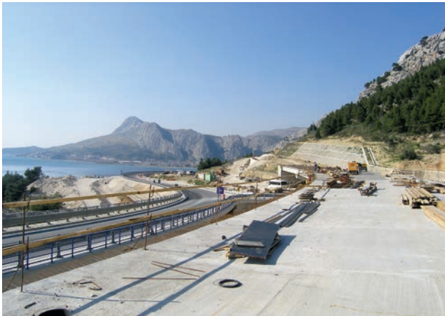
Radovi u čvoru Omiš (prvi posjet)
