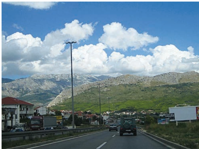
Rekonstruirani dio obilaznice kroz Kaštela
