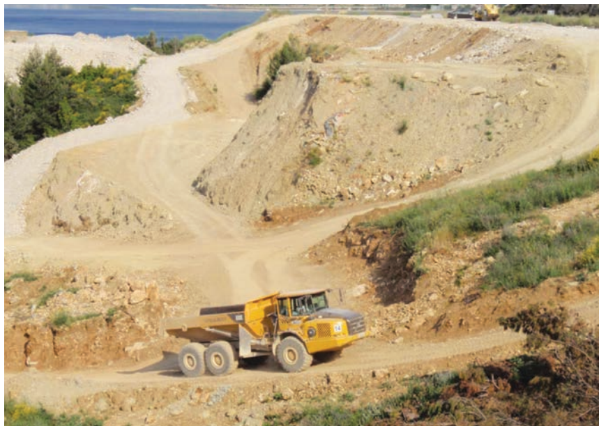
Početni radovi u čvoru Omiš (2009.)
