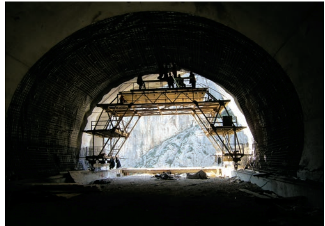
Radovi na portalu tunela Omiš iznad Cetine (prvi posjet)
