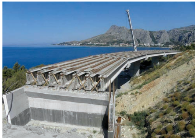
Gradnja vijadukta Čvor Omiš 2 (2011.)
