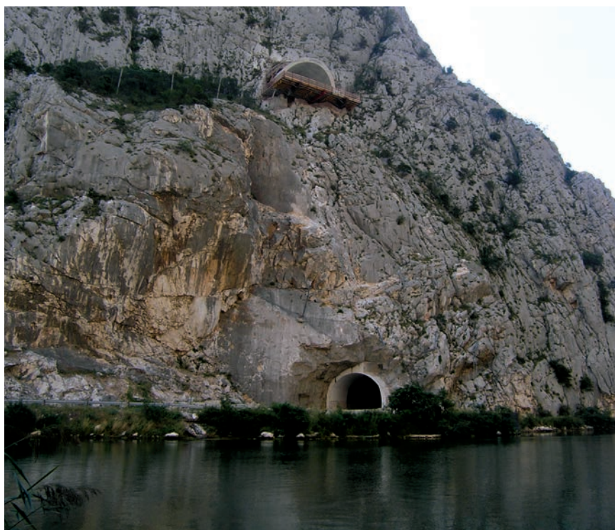
Tunelski portali u kanjonu Cetine – na obilaznici (gore) i županijskoj cesti (dolje)
