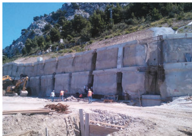
Potporni zid s roštiljnom konstrukcijom (2014.)
