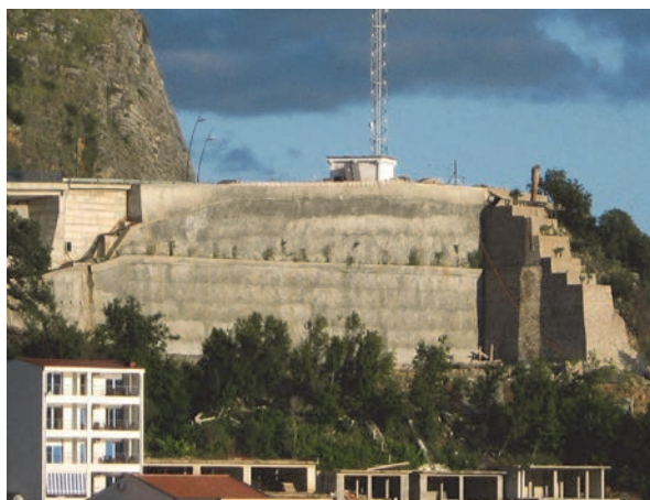
Slika 11. Izgled stabiliziranog iskopa nakon primjene tehničkog rješenja [28]
