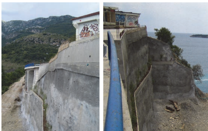
Slika 10. Izgled osiguranog iskopa i detalj južnog dijela iskopa [28]
