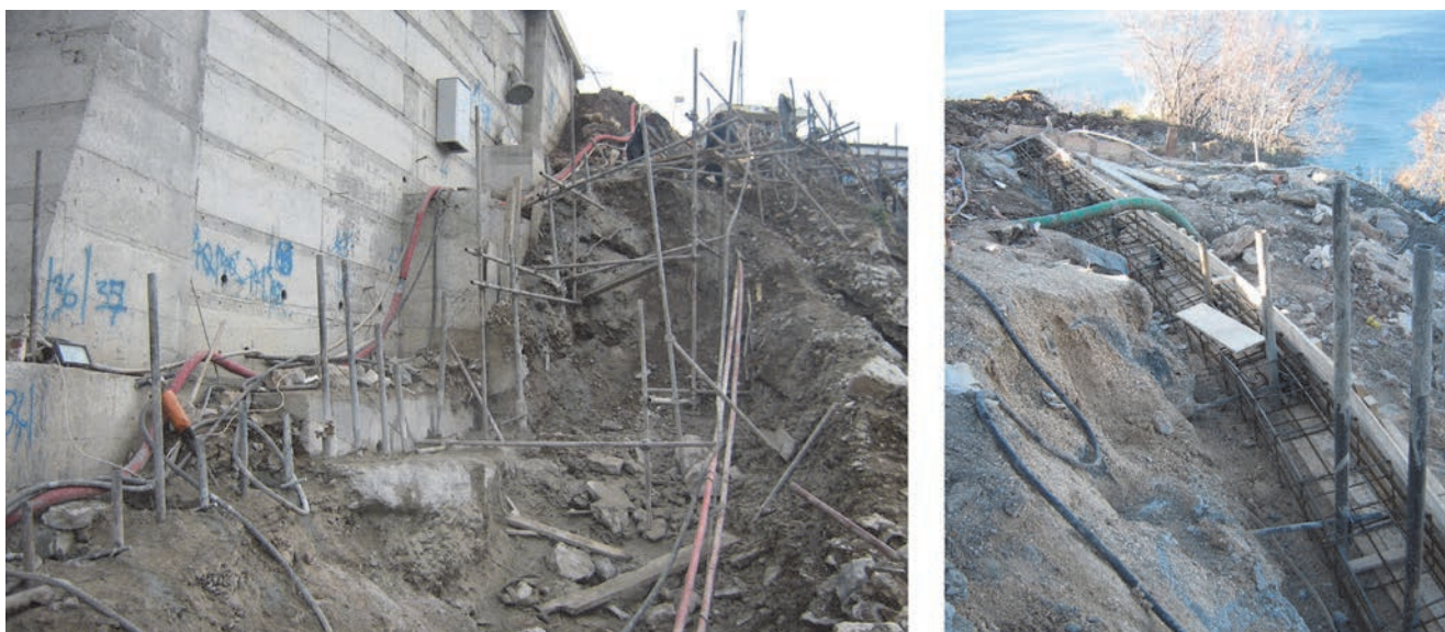
Slika 6. Izrada mikropilota po obodu budućeg iskopa (lijevo) i formiranje naglavne grede (desno) [28]
