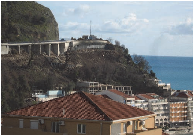
Slika 7. Izgled i detalj iskopa na polovici projektirane dubine [28]
