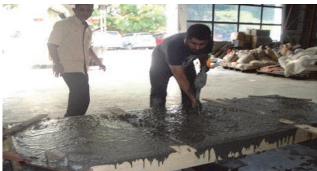
Slika 7. Ugradnja betona u fazi izrade spregnute ploče
