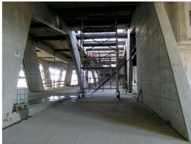
Radovi u prizemlju
