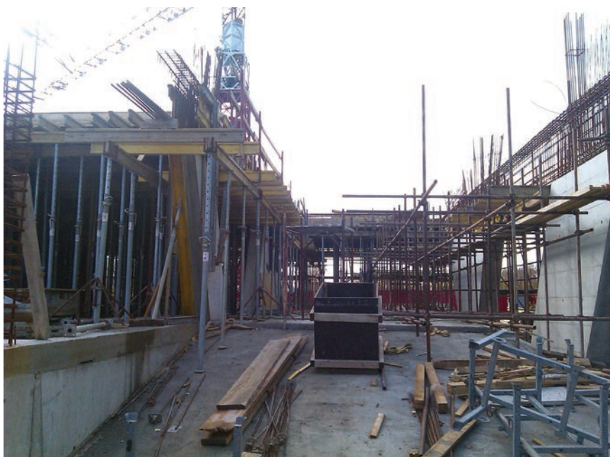
Radovi na gradilištu krajem 2012. godine
