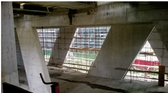
Detalj visokostijernih nosača u gradnji
