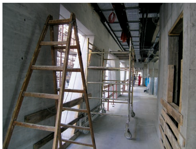
Radovi unutrašnjeg uređenja zgrade
