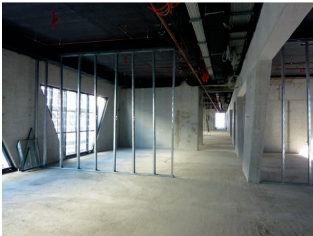
Dio zgrade s ugrađenim instalacijama
